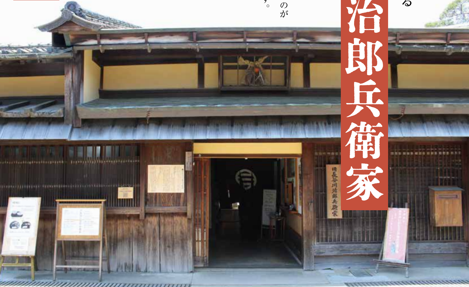
魚町通りに面して広い間口をもつ旧長谷川治郎兵衛家。正面の構えは本うだつを上げ、軒下に幕板を付しています。向かって右側には板塀で隠されていますが、貴人用の門があり、入ると大正座敷の表の間につながります
