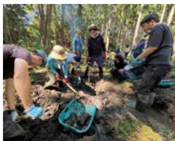
8月に3日間行われたワークショップには延べ100人が参加。粘土質の土を取り除く作業に、みなが精を出す
